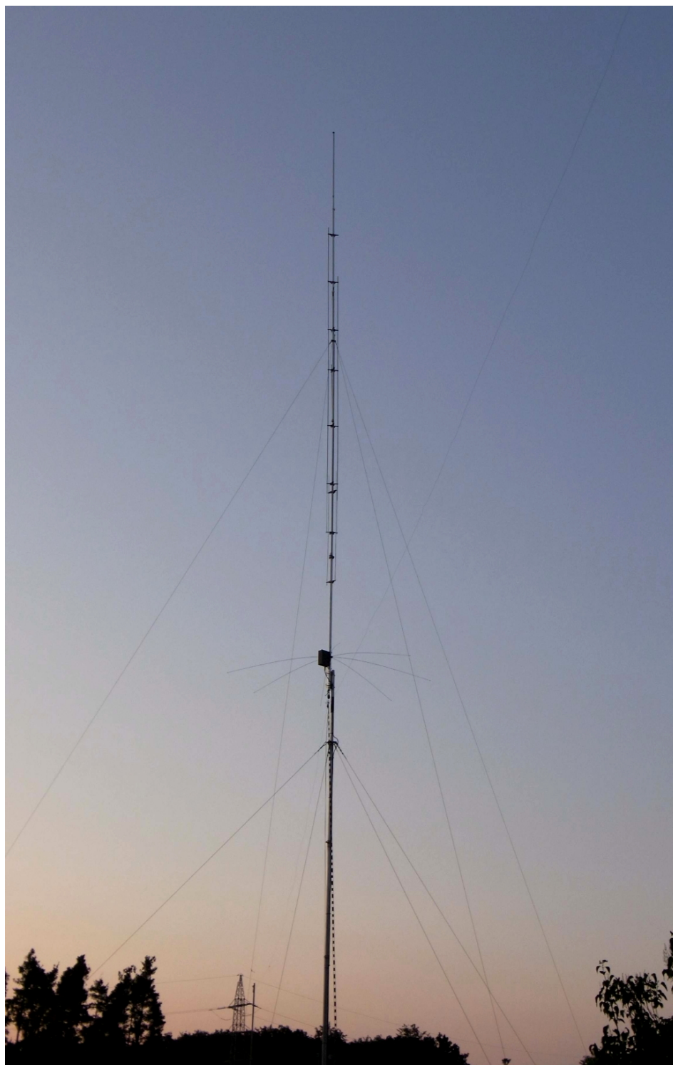
Die AV-620 bei DL1FCU (Montagehöhe 9 Meter). Foto: DL1FCU
